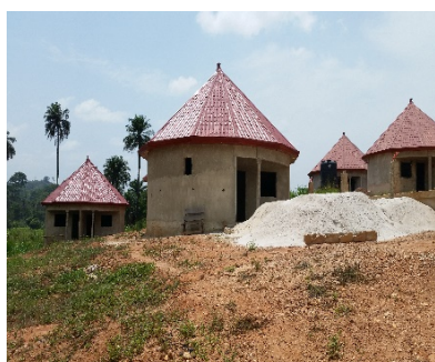
Chantier de case dure à Ghotey-Koly
